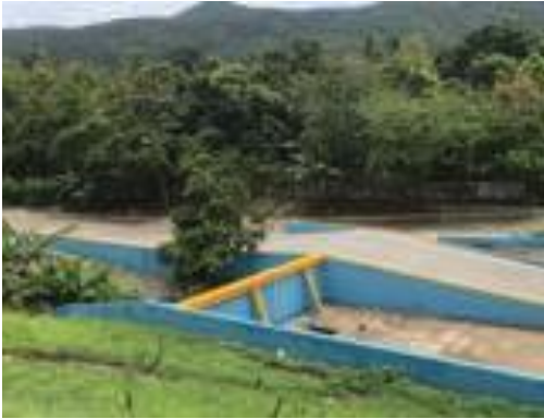
2018 | Construcción de rampa y muro de contención en Central Hidroeléctrica Nizao – Najayo, San Cristóbal
